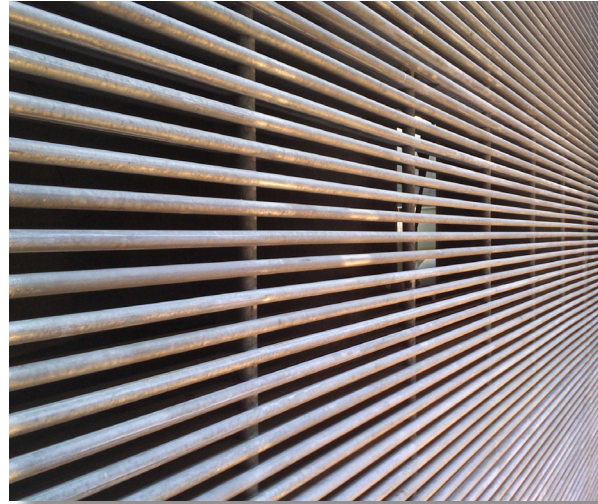
Abbildung 1: Horizontalrechen mit 20 mm lichter Stabweite beim Dotier-Kraftwerk des KW Rüchlig (Bild: WFN).
