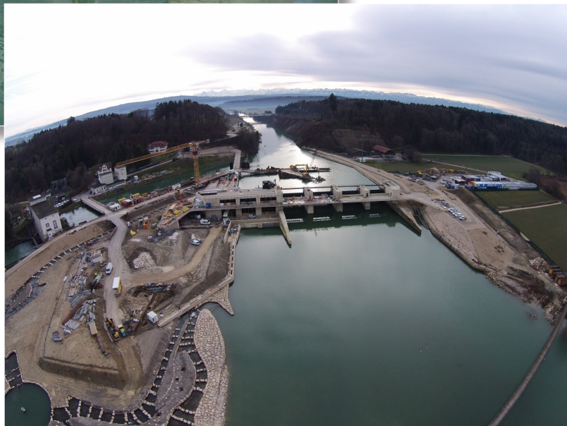
Abbildung A3-1: Oben: das denkmalgeschützte alte KW Hagneck mit 5 Maschinen (3 Propeller- und 2 Kaplanmaschinen vertikalachsig). Unten: Luftaufnahme des Neubaus Wehr und Maschinenhaus an der Mündung des Hagneckkanals (Drohnenaufnahme: BKW Energie AG).
