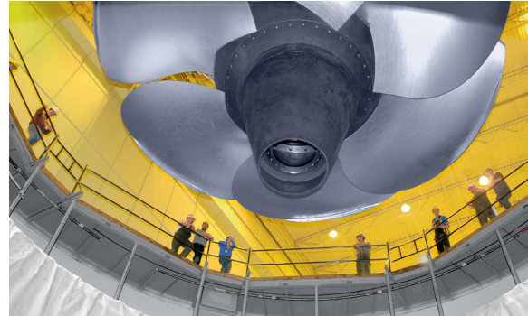
Abbildung 19: Grosse Kaplan turbine im Wasserkraftwerk Wanapum, USA (Foto: Voith Hydro).
