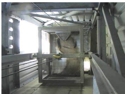
Videoaufnahmen neben einem Fischpass (oben, Aquarius) sowie in einem Fischlift (unten, KWO)
