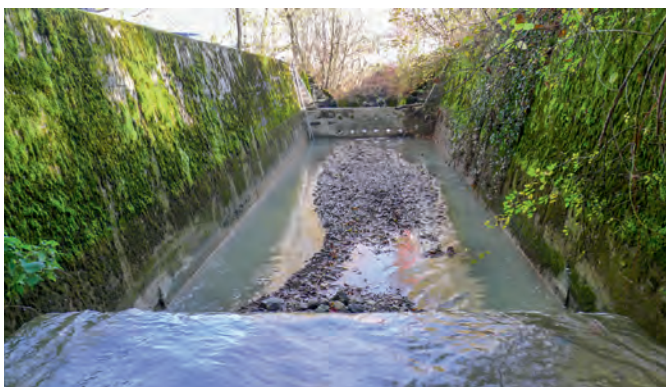
Geschiebesammler Steigbach, Winterthur (links) und Rotensteinbächli, Bauma (rechts)
