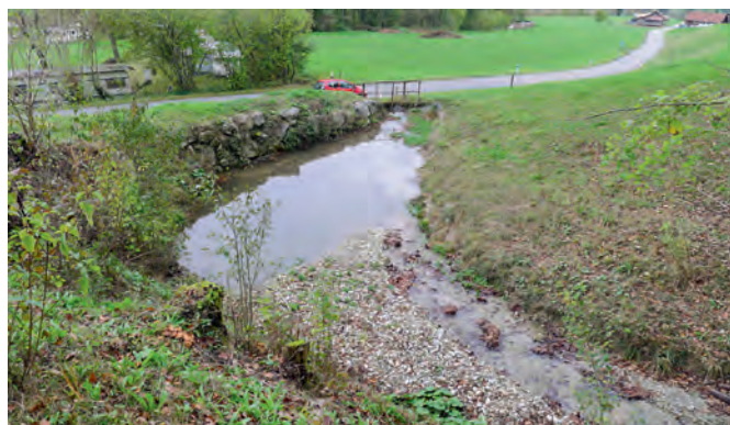
Geschiebesammler Steigbach, Winterthur (links) und Rotensteinbächli, Bauma (rechts)
