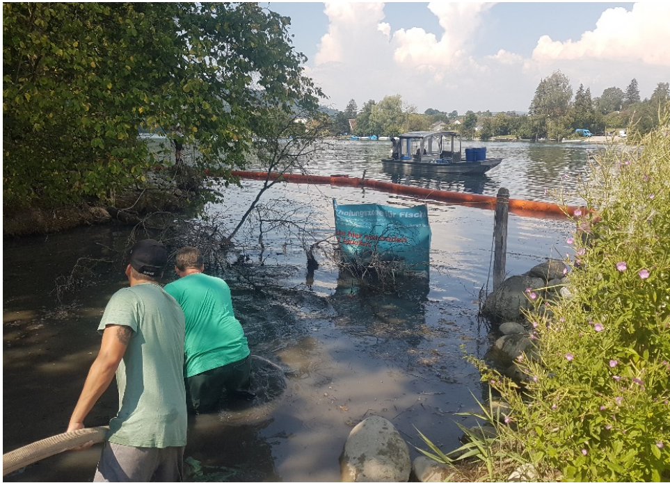
Freispülen von Sedimentablagerungen mit der Feuerwehr
