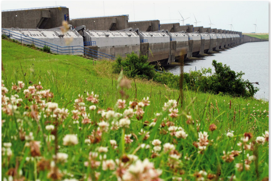
Das Sturmflutwehr Haringvliet wird periodisch geöffnet, damit Wanderfische sich wieder flussaufwärts bewegen können.
